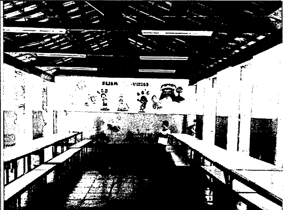
Descrição: REFEITÓRIO EXISTENTE - ESCOLA CORONEL SIMÃO CAMPOS
